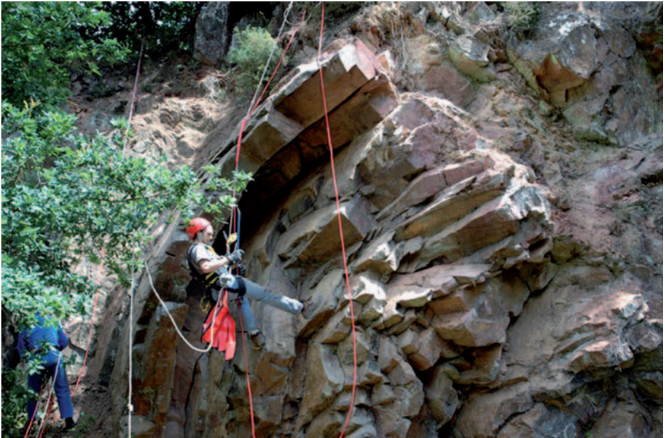
Fig. 3 – Carrière de La Marette (Saint-Malon-sur-Mel) : Discordance Paléozoïque/Briovérien. Travaux de gestion. Espace naturel sensible départemental – Île-et-Vilaine. Photo M. Jonin.
