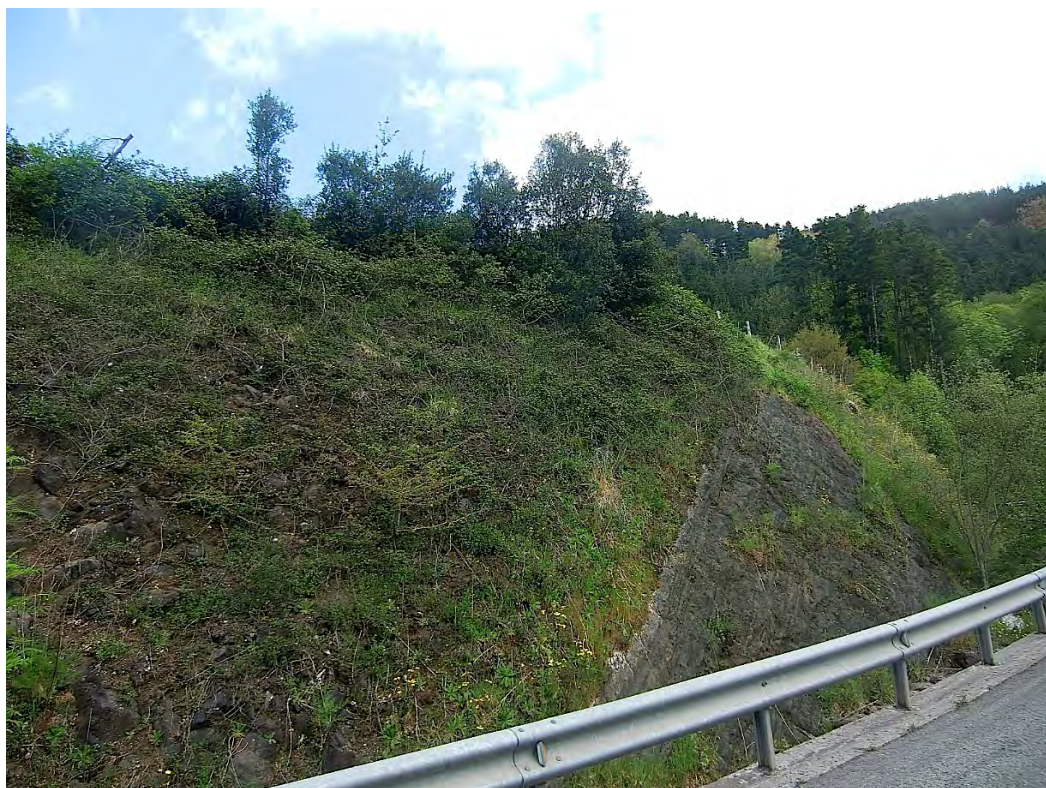
Contact inférieur de la coulée de pillow lavas, reposant sur un niveau de brèches volcaniques finement stratifiées
